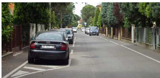
Figura 32: Chicane ricavata con il posizionamento di stalli per la sosta a Cassano d'Adda
